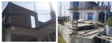
भानु पुस्तकालय भवन निर्माण
