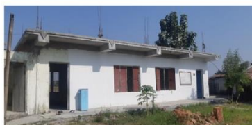
भानु पुस्तकालय निर्माण
